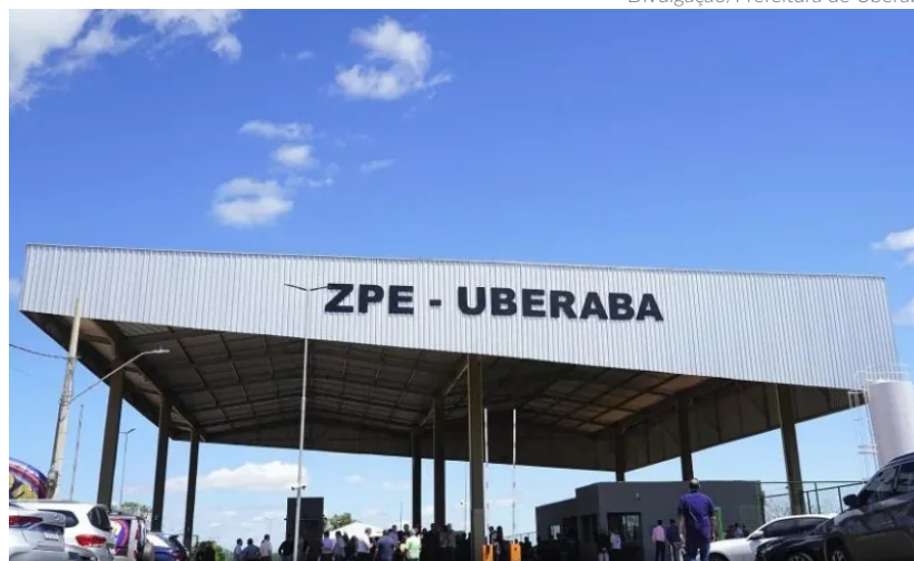
A ZPE da cidade mineira oferece, nesta primeira etapa, dez lotes disponíveis, com novas áreas e infraestrutura planejadas para expansão conforme as vagas forem ocupadas
