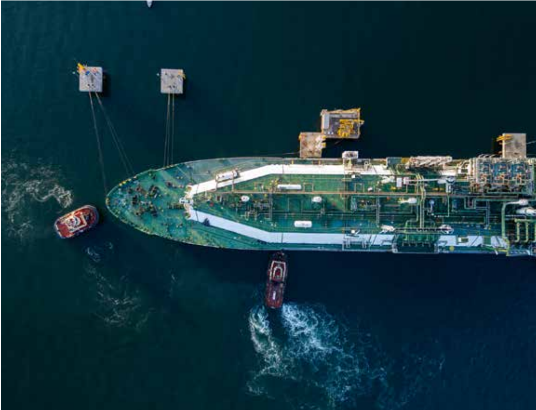
O terminal offshore tem um sistema de dutos de aproximadamente 32,6 quilômetros e estação de transferência de custódia e condicionamento de gás (ETC) em Garuva (SC)
