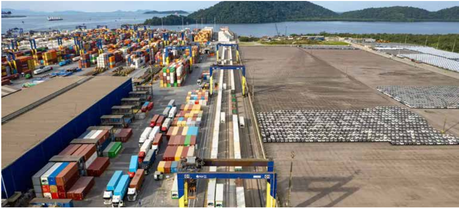
A nova estrutura adiciona 757 metros de ferrovia ao pátio e deve contribuir para um crescimento de aproximadamente 20% na movimentação de cargas pelo modal até 2027
