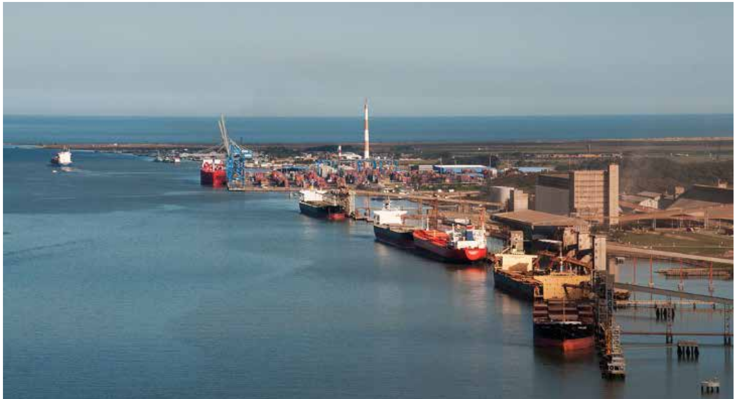
O projeto prevê a construção de dois berços para navios e outros destinados a barcas, além de um armazém com capacidade estática para 194 mil toneladas de celulose
