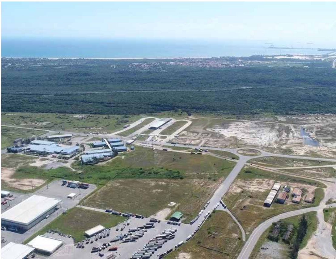
O data center a ser implantado na ZPE do Ceará será ocupado pelo TikTok e construído pela Omnia, empresa do grupo Pátria Investimentos, em parceria com a Casa dos Ventos
