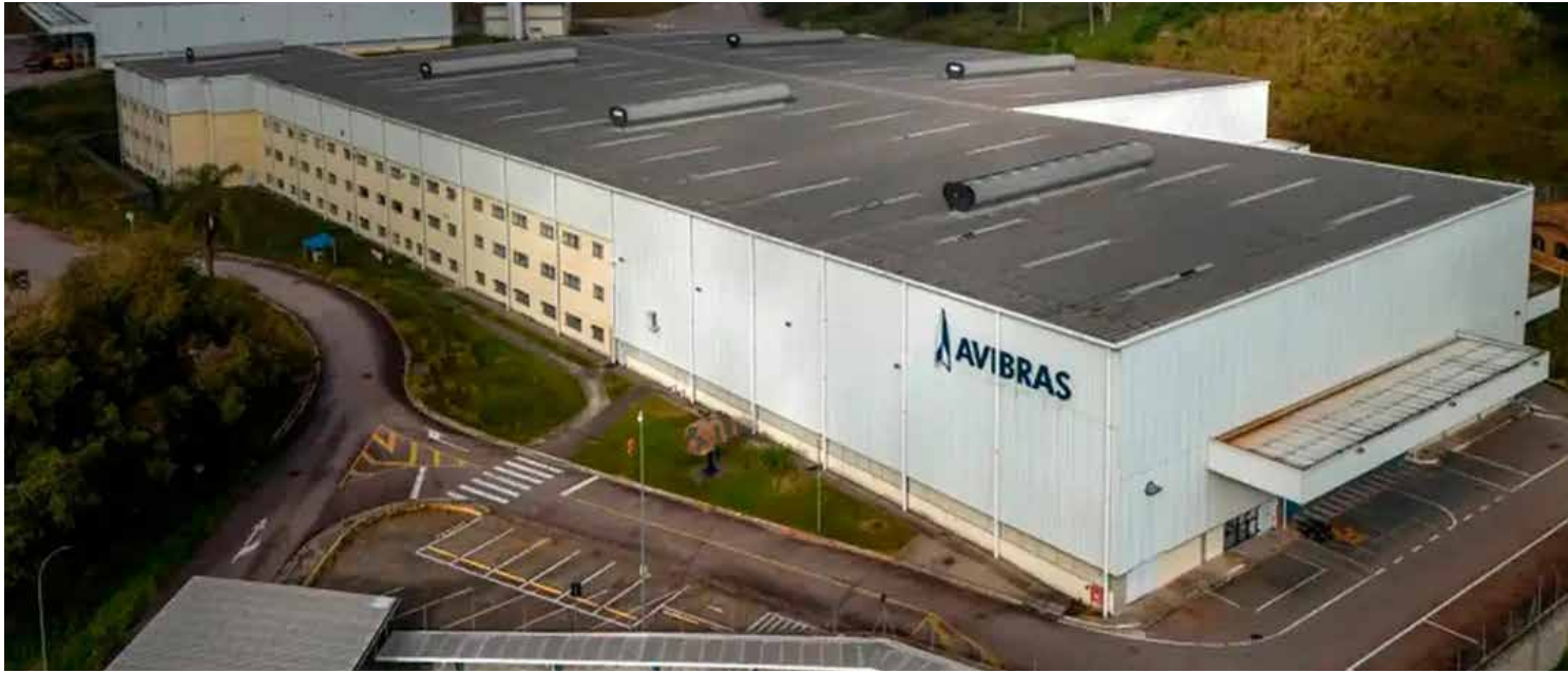
A Avibras Aeroco foi constituída no âmbito do processo de recuperação judicial da antiga Avibras, referência internacional no desenvolvimento e na fabricação de sistemas de defesa
