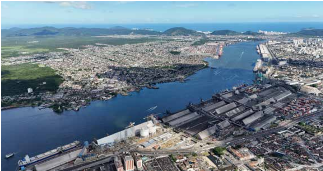
A modernização da segurança do complexo portuário de Santos, incluindo áreas do canal, perimetrais e demais instalações, terá investimentos de aproximadamente R$ 62 milhões
