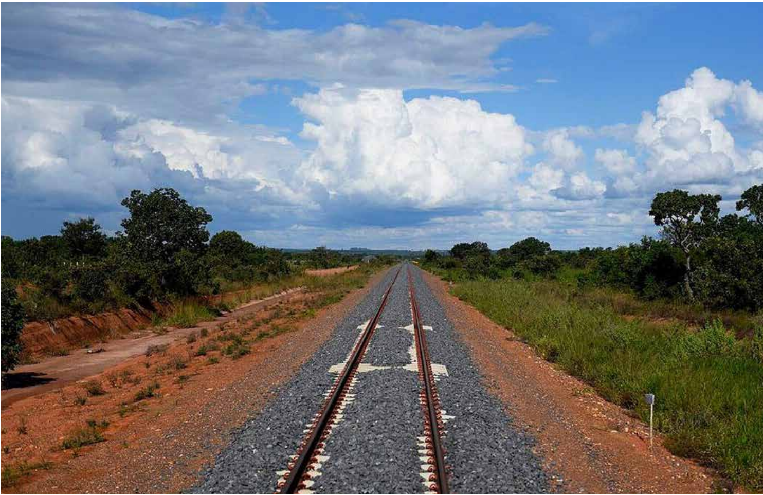
O projeto da Ferrovia de Integração Oeste-Leste (Fiol), na Bahia, teve início há 18 anos e, segundo os dados apresentados, cerca de 75% das entregas previstas foram concluídas
