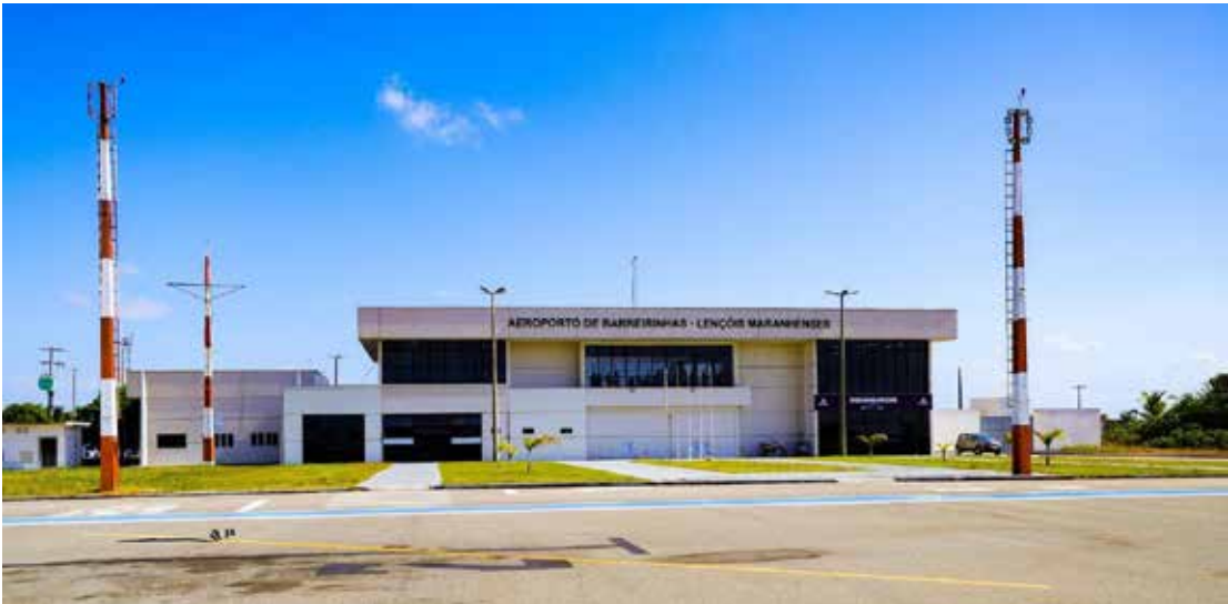
As obras em Barreirinhas fazem parte da primeira etapa do AmpliAR, iniciativa alinhada ao Plano Aeroviário Nacional, que projeta a modernização de 100 aeroportos regionais
