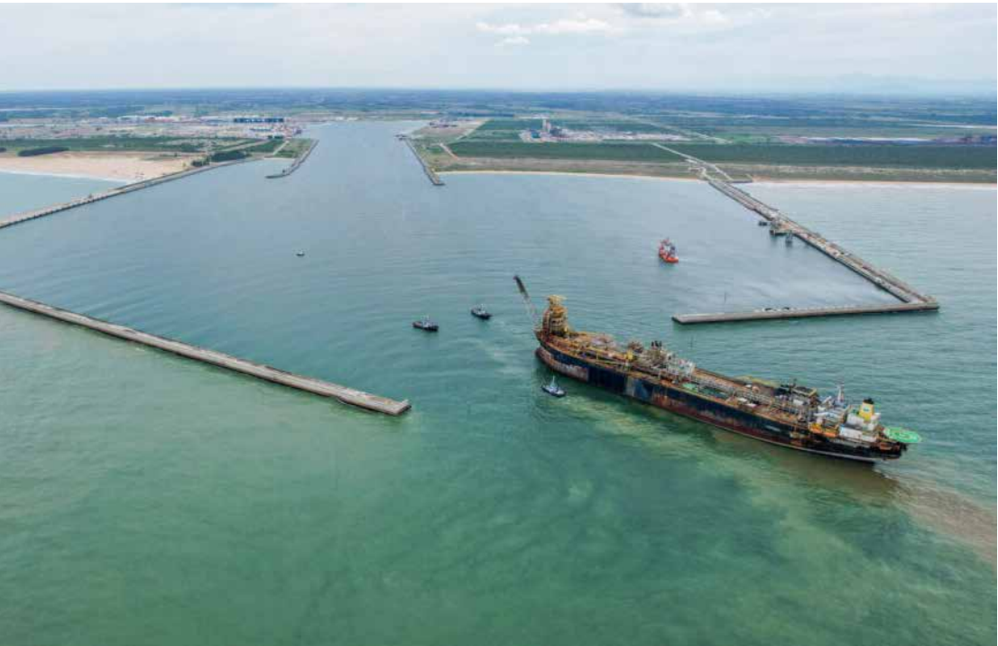
A iniciativa prevê a instalação de um cabo submarino de 80 quilômetros entre o complexo portuário fluminense e as unidades da petroleira nos polos Pargo e Cherne, em águas rasas
